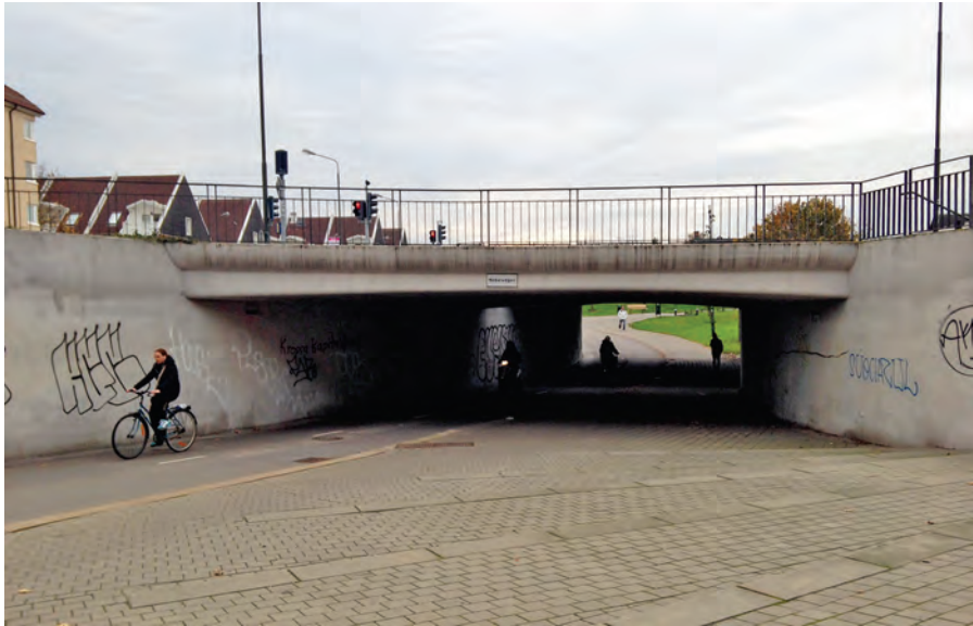
Bild 39. Gång- och cykeltunneln under Nobelvägen.
