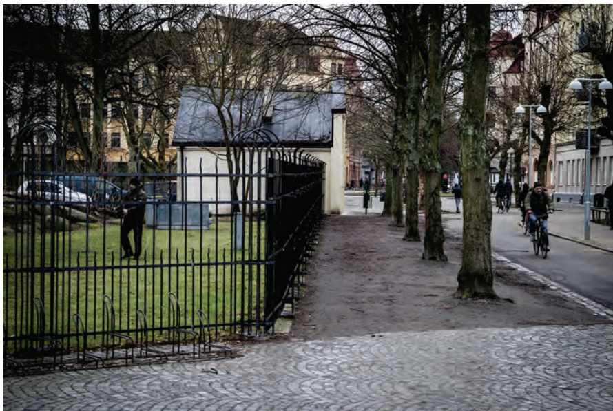
Bild 16. Ibland är de olika administrativa gränserna synliga i stadsrummet. Inhägnaden av Folkets Park i Malmö är ett exempel på en synlig administrativ gräns. Folkets Park, till vänster om smidesstaketet, är kvartersmark. Planteringen och cykelbanan till höger om smidesstaketet är allmän plats. Båda områdena förvaltas av gatukontoret i Malmö. Grindarna till Folkets Park stängs nattetid. Folkets Park är offentlig plats under de tider på dygnet som parken är öppen för allmänheten.
