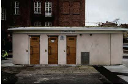
Bild 18. Kommunal offentlig toalett i Malmö. Gatukontoret förvaltar ett 50–60-tal små byggnader, främst offentliga toaletter och bussterminaler (intervju: Upphandlaren 2014).
