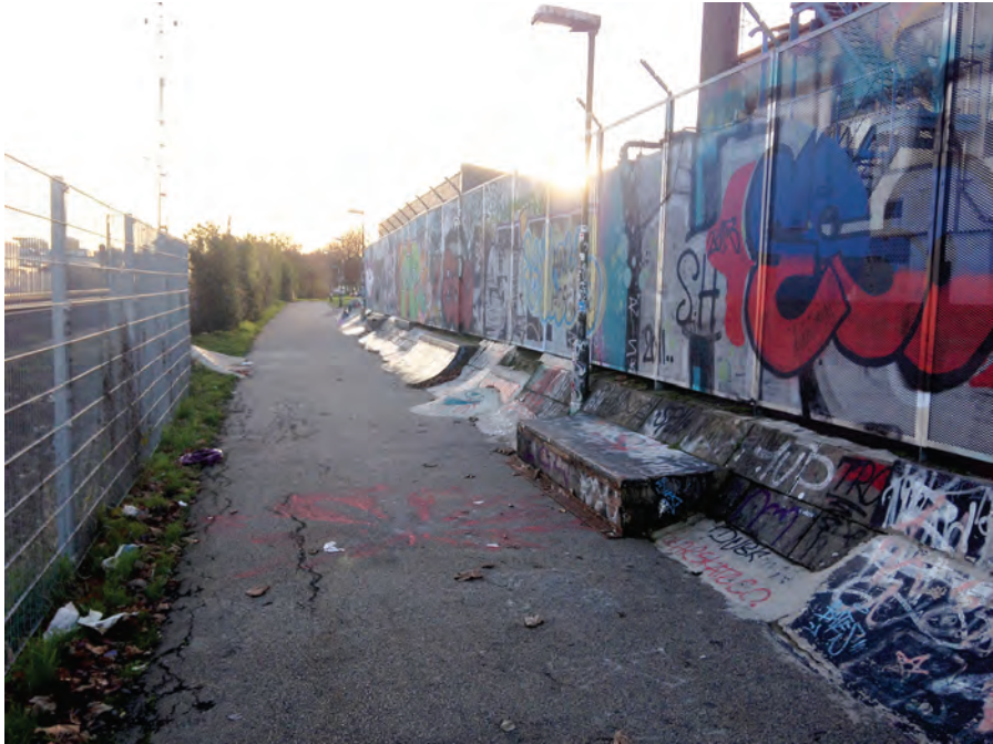
Bild 33. Egenmäktigt byggda skejtramper vid Branteviksgången.
