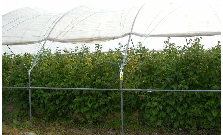
Tunnlar kan luftas genom att plasten på sidorna lyfts upp.
