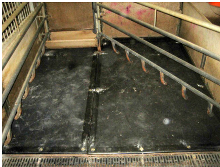
Figur 2. Mattorna fästes i hörn och kanter med brickförsedda betongspikplugg. (Foto: R. Westin)
