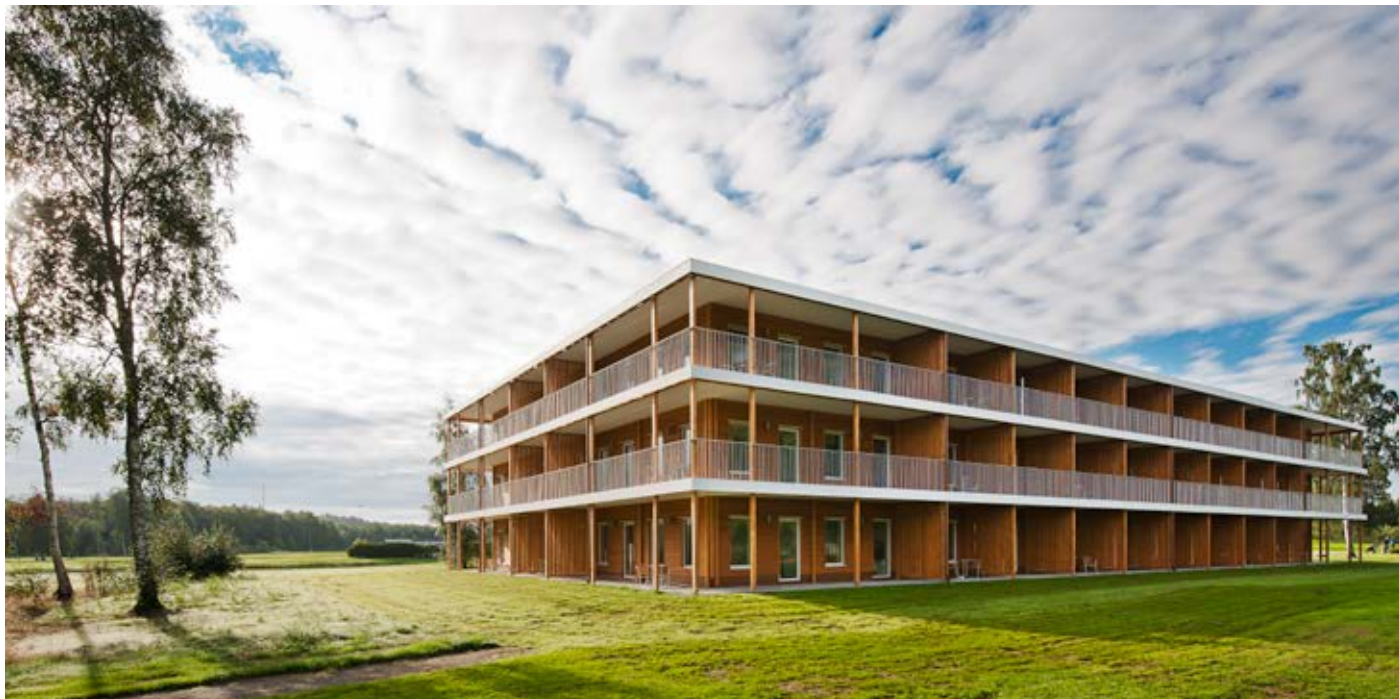
Lindöpark hotell. Foto: Moelven Byggmodul AB.
