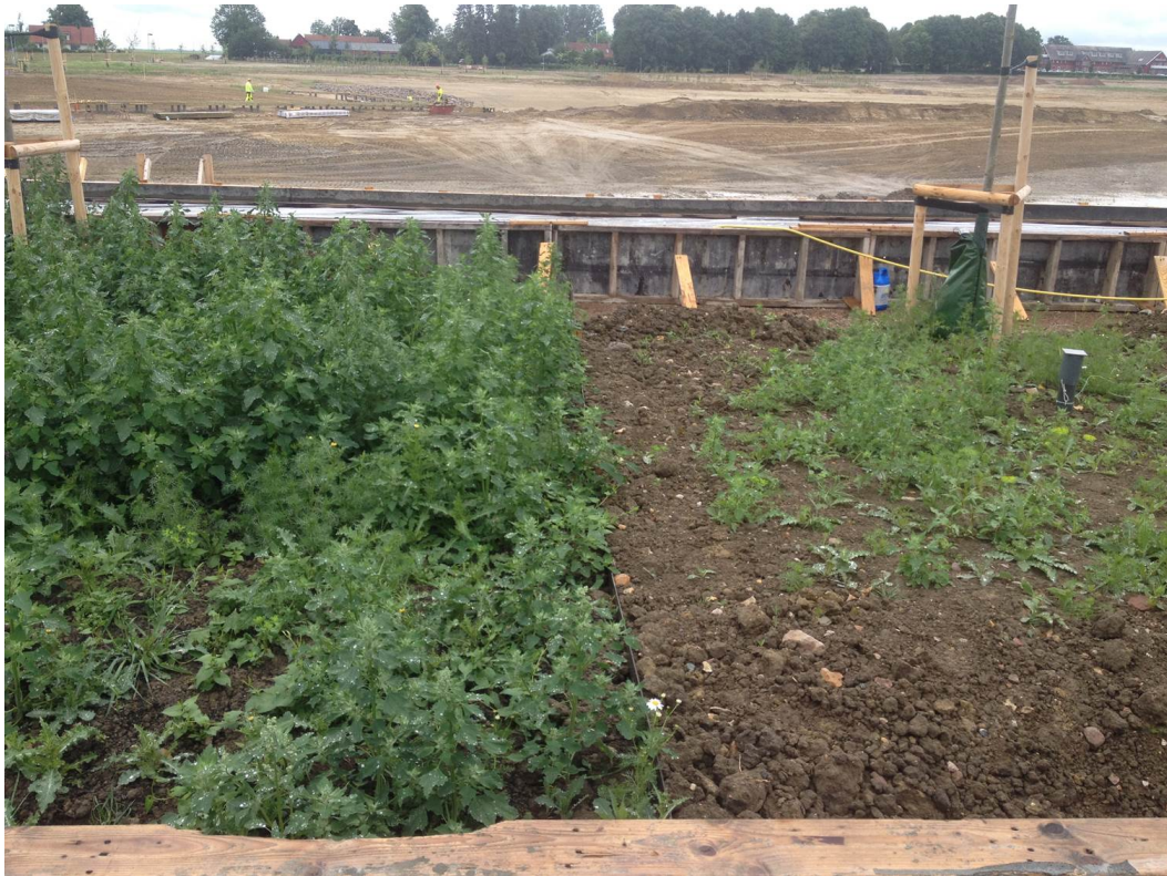
Figur 2 visar den tydliga skillnaden i ogräsutveckling mellan den biokolsberikade växtbädden (till vänster) och den utan biokol (till höger). Cortenstålsavdelaren kan anas under ogräset och bilden är tagen innan betonggjutningsformarna togs bort och före slitlagret lades dit. Det som ska bli sjön syns i bakgrunden.
