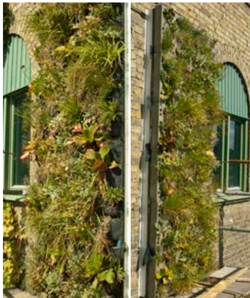
Foton som visar systemen med fickor respektive mineralullspanel den 27 august 2012. Foto: Annika Wuolo.
