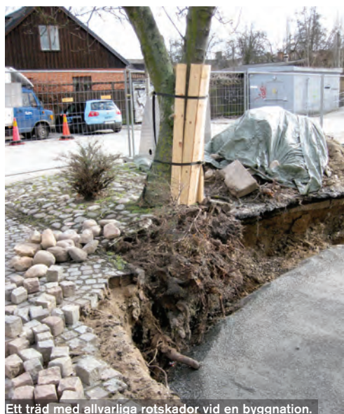
Ett träd med allvarliga rotskador vid en byggnation.
