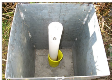
Figur 5. Grundvattenrör. Foto: Maria Blomberg
