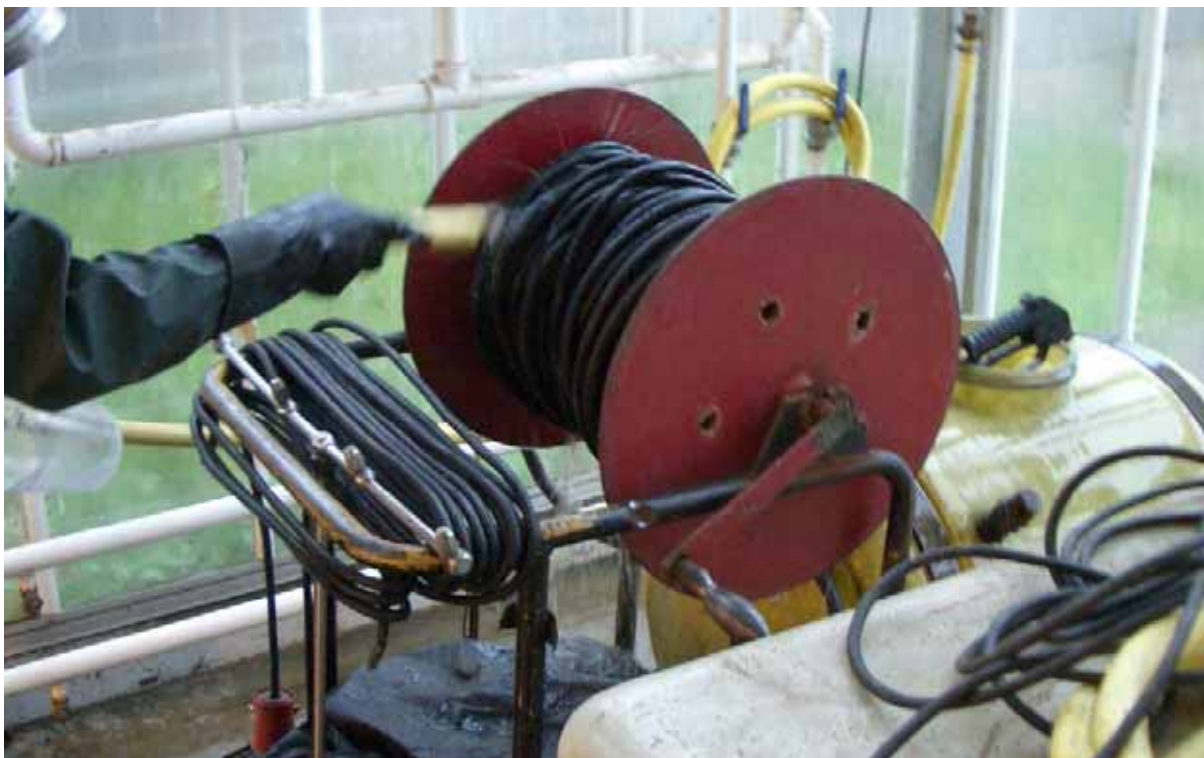
Figur 11. Utvändig rengöring av spruta på platta, som är kopplad till biobädd (syns i bakgrunden utanför glaset).
