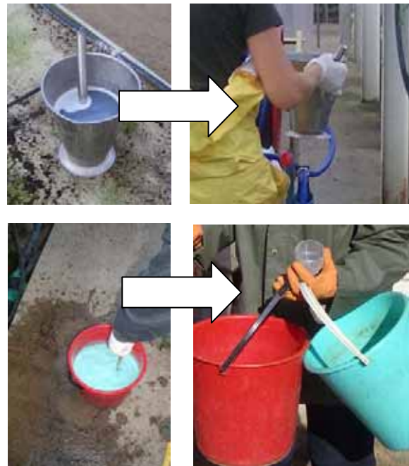
Figur 3. Transport av det uppslammade blandningen till sprutplatsen (spillrisk).
