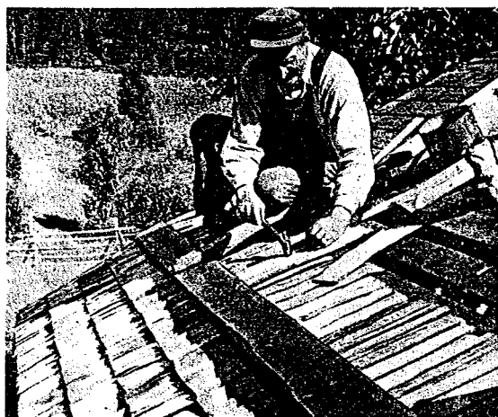
Bild. 1 Påläggning av spåntak.
