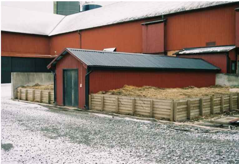
Figur 25. Exempel på öppet horisontellt biofilter (Brogården, Skara)
