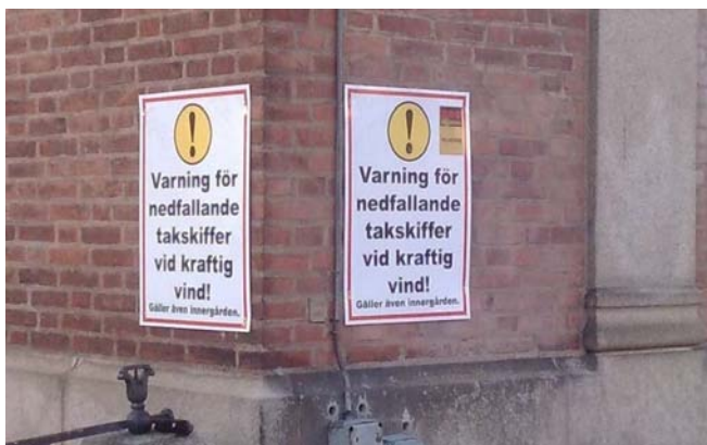
Figur 6: Varningsskylt Kungsladugårdsgatan, Göteborg. En del fel upptäcks först i användningen, sent i livscykeln.
