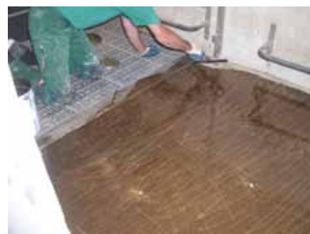
Figur 2. Betongytan beläggs först med en "primer".
