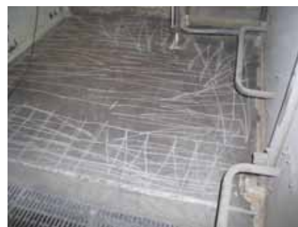
Figur 1. Spår slipas upp i betonggolvet.
