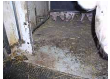
Figur 5. En liten skada i gummigolvet under vattennippeln.
