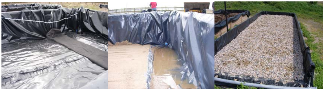
Figur 1. Provyta av geotextil/grus med lågpunkt och utlopp för läckvätska längst till vänster. Ovanpå PVC membranen fylldes ett lager upp med grovsand för att samla läckvätska till läckvätskeutloppet. En geotextil separerade grusen i utloppsdiket från sandlagret. Därefter följde geotextiler samt grusmaterial. Färdig provyta till höger.
