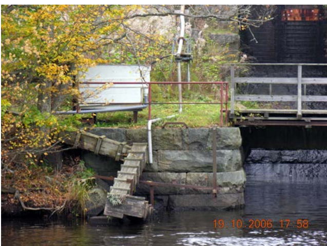
Figur 5 - Ålledare och uppsamlingslåda i Mörrumsån. Kraftverket ligger till höger i bilden. Uppvandrande ålar klättrar genom en träränna fylld med ett substrat som hålls fuktigt genom ett bevattningsrör och leds till en glasfiberbehållare (sump) på toppen. Från den hanteras ålarna manuellt, vägs och transporteras vidare.
