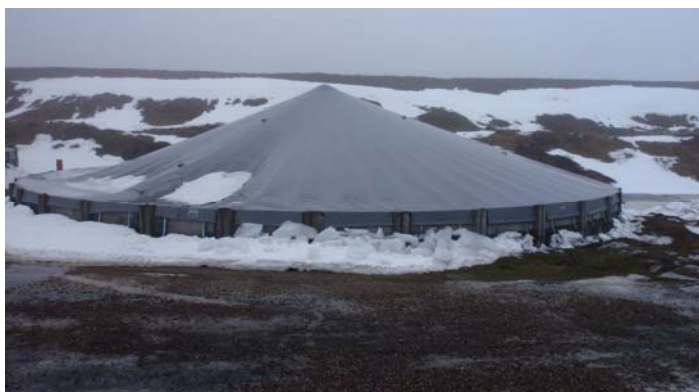
Figur 5.9. Snöansamling på spänntak över gödselbrunn.
