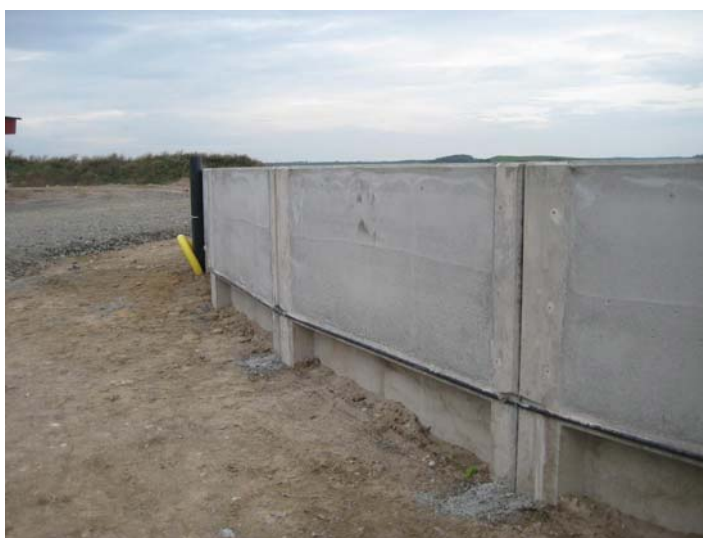
Figur 5.10. Förstärkning genom pågjutning av behållarvägg innan spänntak monteras.
