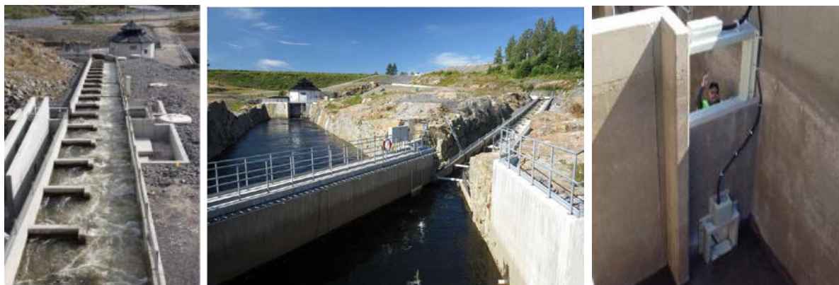
Figur 11 visar fisktrappans övre del med tvärställda PIT-antenn (vänster bild)(sedd från uppströms) samt fisktrappans difusor område där uppströmsvandrande lax vandrar in (bild i mitten). Till höger i bild ses placeringen för PIT-antenn i en av kammarrappans fack för övre och nedre öppningsdel.
