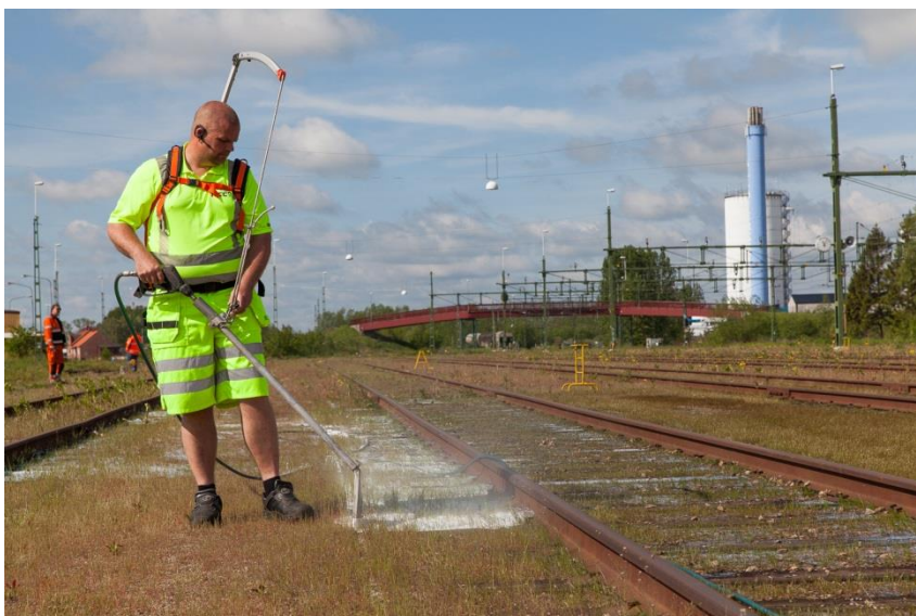
Figur 2. Utläggning av hetvattenscummet med sprutmunstycke.
