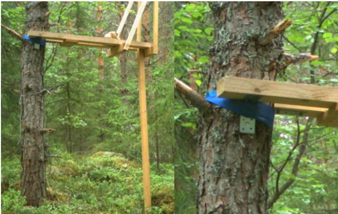
Bild 3. Ställning monterad mot träd (vänster) och närbild på fästet med vinkeljärn och spännband (höger)
