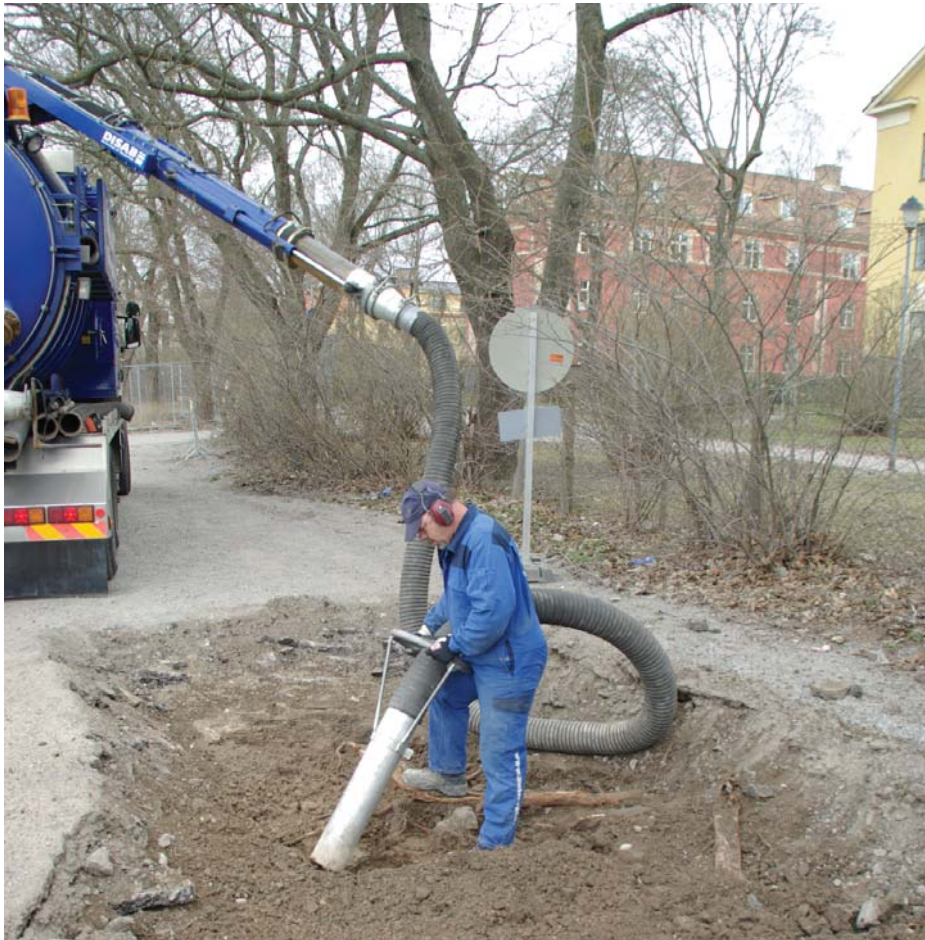
Vakuumschakt vid en rotkartering.
