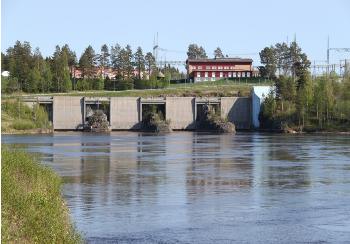
Bild visande de fyra turbinintagskanalerna till Generator 1 (G1) till och med generator 4 (G4) till Sveriges största energiproducerande vattenkraftverk i Stornorrfors med en total slukförmåga på ca. 1000 m 3 /s och fallhöjd på 76 meter. (Foto: R. Karlsson/SLU)
