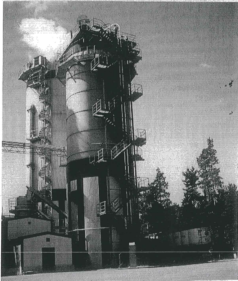
Bild 3:3. Bränslesilo vid Jordbroanläggningen. Silon rymmer 800 m 3 pulver. Parallellt med silon står akumulator tanken.
