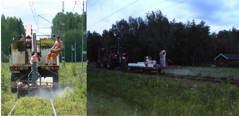
Figur 8. Vänster: sprutning med spårgående lastbil som dragfordon. På bilden sprutas vattnen för att föraren ska kunna öva in rätt färdhastighet på sträckan Kilafors-Söderhamn, 2007. Höger: sprutning av ättika i fältförsök på Bohusbanan, 2009. Tekniskt ansvarige Carl Westberg sköter sprututrustningen i båda fallen.
