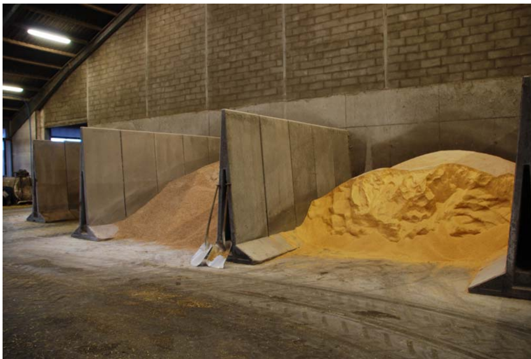
Bild 93. Flyttbara betongblock ger flexibilitet. På bilden är det spannmål och majs i fickorna.
