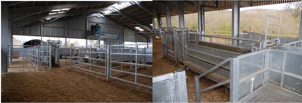
Bild 53-54. Olika detaljer från hanteringsanläggningen.
