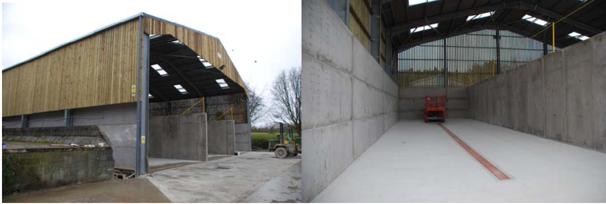
Bild 3 och 4. Nybyggd stor plansilo (12 x 6 meter) med tre stora fack och brunn med tank för uppsamling av pressvatten.
