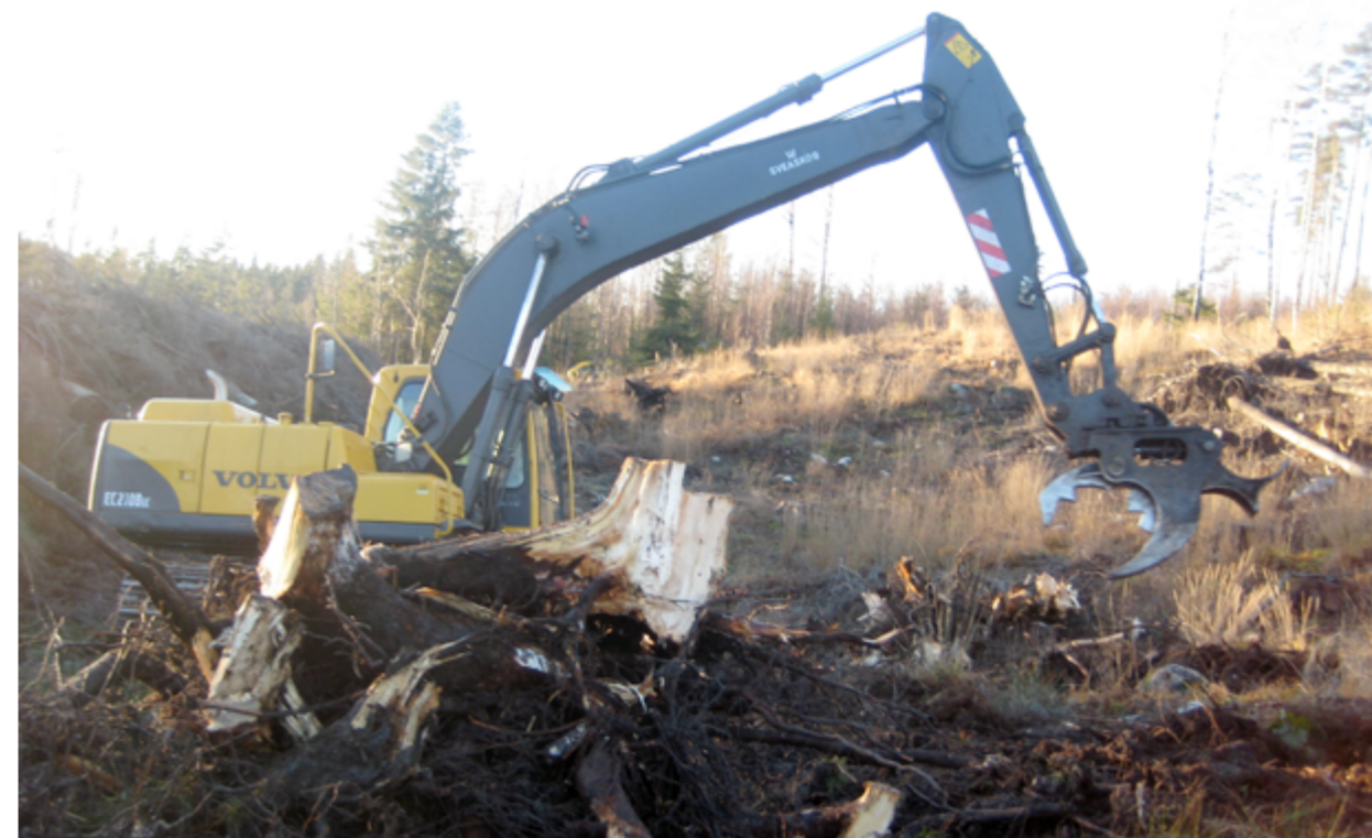
Stubbskörd kan innebära fler stående vattensamlingar i körskador och håligheter efter borttagna stubbar. Det är miljöer där mycket metyl-Hg kan bildas.
