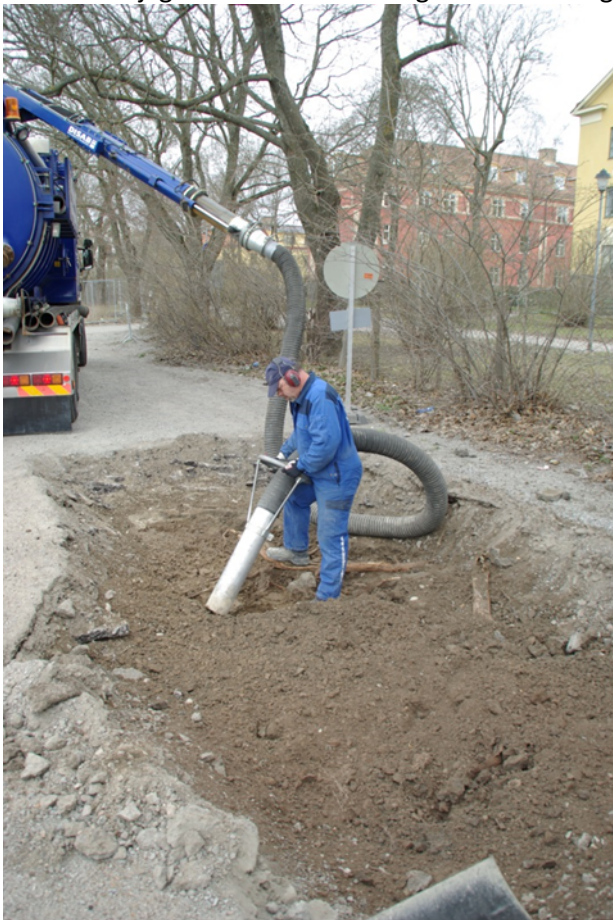
Figur 2. Rotkartering med vakuumschakt.
