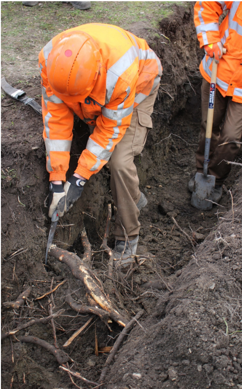
Figur 3. Trärötter som måste avlägsnas vid schakt beskärs med beskärningsverktyg (handsåg).
