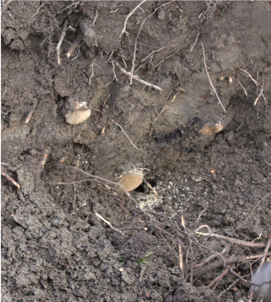
Figur 4. Korrekt beskurna rötter vid schakt.
