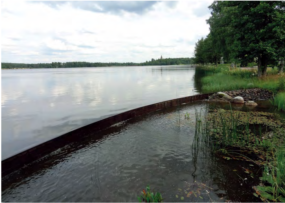
Figur 47. Trummens utlopp där en låg damm etablerats för att hålla vattennivån och förhindra uppvandring av fisk. De betar ju på djurplankton som är viktiga för att kontrollera växtplankton. Foto: Erik Degerman.
