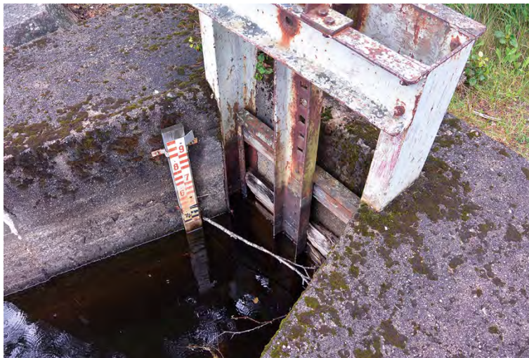
Figur 15. Här har man installerat en pegel vid regleringsluckorna, något som underlättar för verksamhetsutövaren att följa eventuella tillstånd och för länsstyrelsen att utöva tillsyn. Foto: Johan Törnblom.
