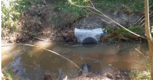
Figur 5. Nät som hindrar fisk från att komma ut vid tömning av dammen. Foto: Mats Envall, länsstyrelsen i Hallands län.
