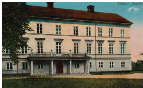
Fig 8. Äldre vykort som visar huvudbyggnaden med de tre våningsplanen. Fotot är från ett odaterat vykort. Det enda som kan sägas är att vykortet är äldre än 1968–69 eftersom under dessa år togs den tredje våningen från 1846–48 bort.
