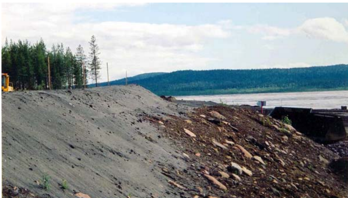
Figur 99. 2002-ytan upplagd ovanpå gamla ytan från 1997. Sandskiktets tjocklek är minst 1 m ovanpå det gamla, metertjocka sandskiktet. Morän i botten.
