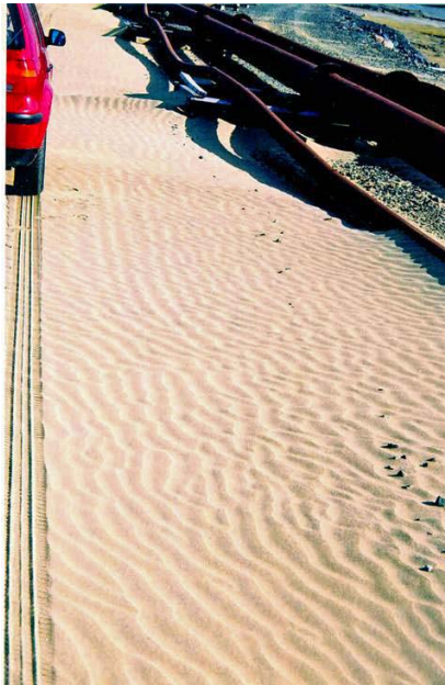
Figur 3. Uppe på sandmagasinets östra damm vall ligger vindtransporterad sand.
