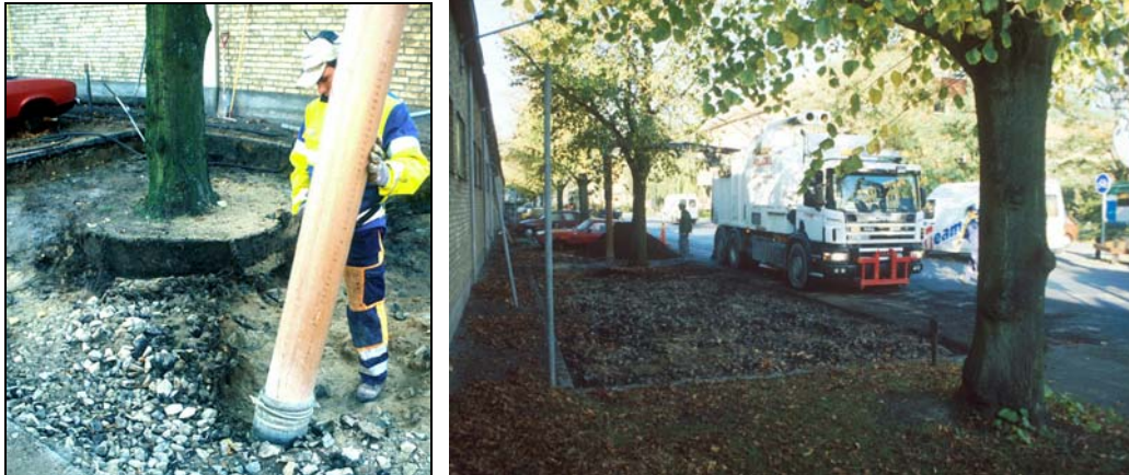
Figur 19. Vacuumsug och urschaktad yta. (Foto: Ö. Stål, 2001).
