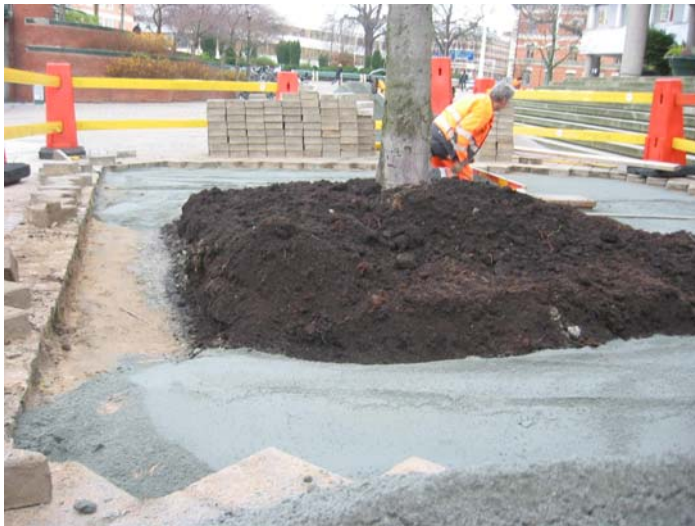
Figur 41. Utläggning ny växtjord i den förstörade bädden och avjämningsmaterial till plattytan. (Foto taget 2004).
