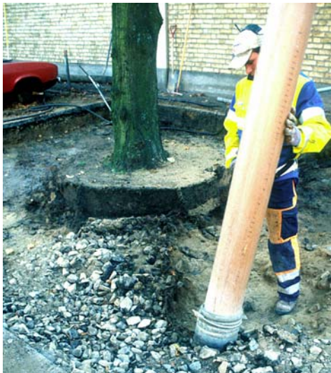
Figur 3. Vakuumsugning på Augustenborgsgatan, Malmö. (Foto Ö. Stål, 2001)
