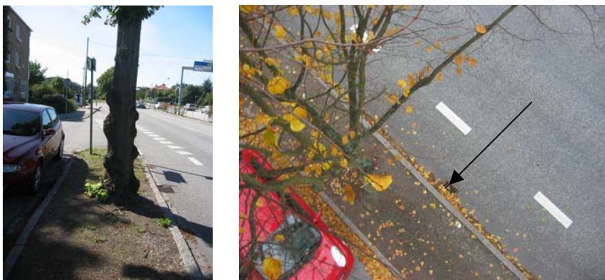
Figur 15. Till höger den smala listen och till vänster brunn för dagvattenledning dit trädens rötter sökt sig.
