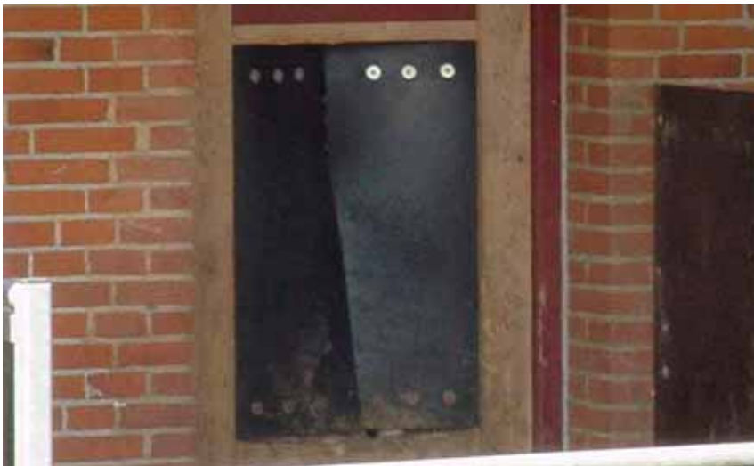
Bild 11. Sidohängda gummiplattor. Plattorna sluter tätt mot väggen så att det inte blir drag.
