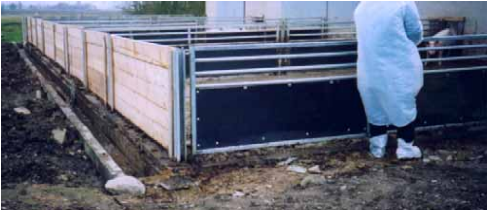
Bild 15. Lutande rastgård med ränna i vilken gödseln däms upp.
