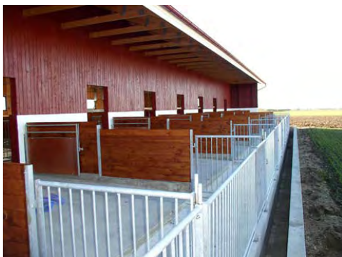
Figur 14. Ekologisk slaktgrisproduktion. Utomhus finns en rastgård som delvis är övertäckt av stallets tak. Betonggolvet på uteytan lutar i riktning mot en gödselkanal där gödsel och urin samlas upp.
