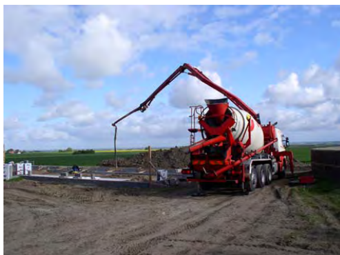
Figur 3. Ekologisk slaktgrisproduktion. Gjutning av grundplatta pågår.
