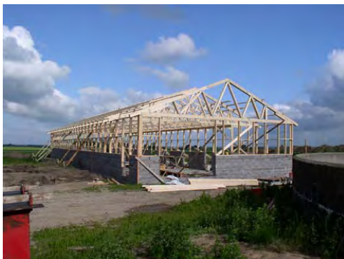
Figur 5. Ekologisk slaktgrisproduktion. Väggarna består nedtill av skalblock eller putsade lättklinkerblock. Den övre delen av väggen utgörs av en träregelstomme och taket byggs upp med fackverkstakstolar.
