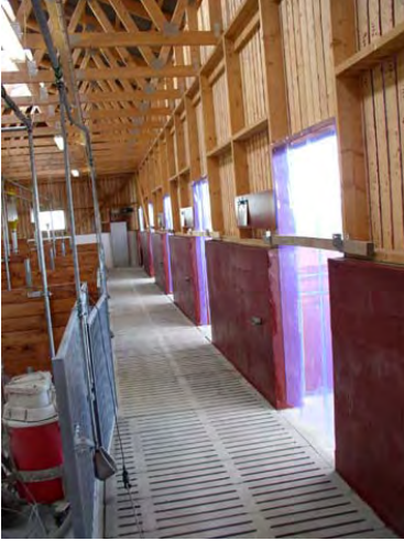
Figur 24. Ekologisk slaktgrisproduktion. Inne i stallet finns en gödselgång med spaltgolv. Undertill finns kulvert och mekanisk skraputgödsling.
