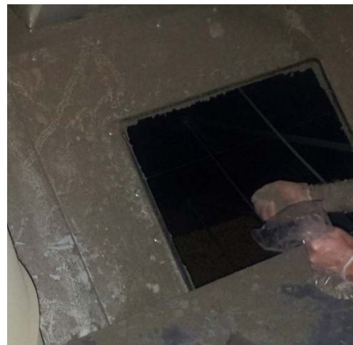
Figur 6. Provtagning av tork via manlucka. Foto: SVA
