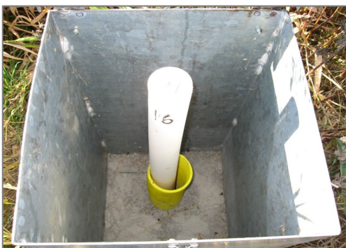
Figur 5. Grundvattenrör. Foto: Maria Blomberg
