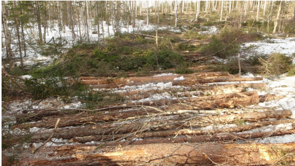
Figur 5. En kavelbro som byggts över en smal myr av en kombination av barrmassaved och grot. Foto: Tomas Nordfjell.
