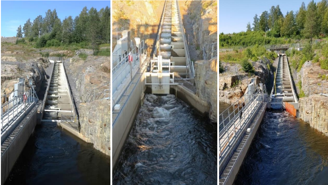
Mellanväggar borttagna i de två nedersta facken, vattnet strömmar fritt genom facken. Foto: Åke Forssén
