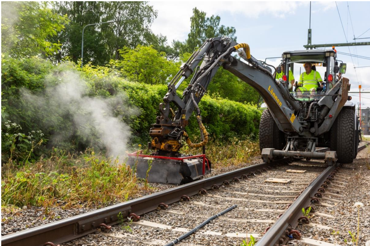
Figur 29. Ramviks Entreprenads utrustning för hetvattenbekämpning. Vattnet finns i en tank på baksidan av traktorgrävaren och hettas upp med hjälp av ett dieselaggregat. Det upphettade vattnet pumpas genom en isolerad slang ut till en rad sprutmunstycken som sitter monterade under en huv på traktorgrävarens arm. Ungefär 1 m breda stråk bekämpas åt gången.
