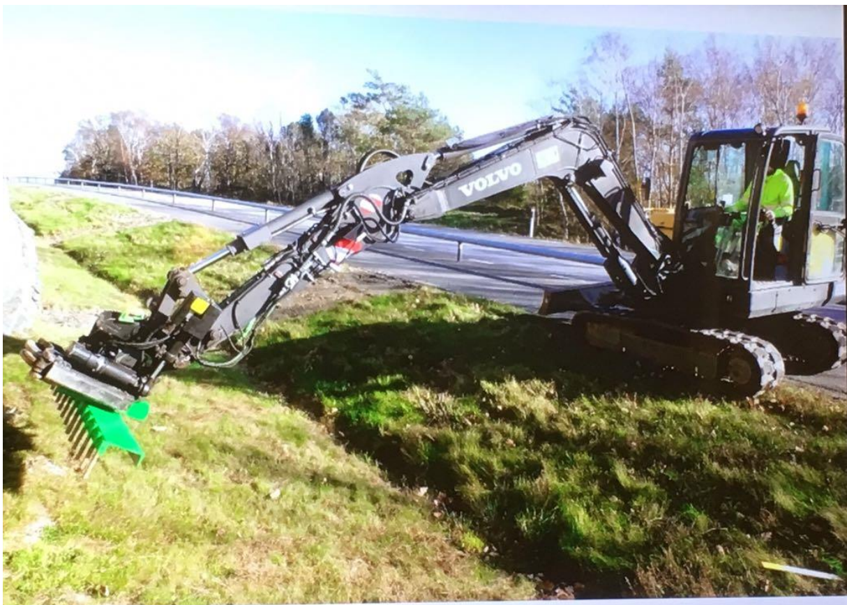
Figur 2. Maskin för skrapning av vägslänt. Bild från Jan-Erik Lundh, Trafikverket 2018-12-21
