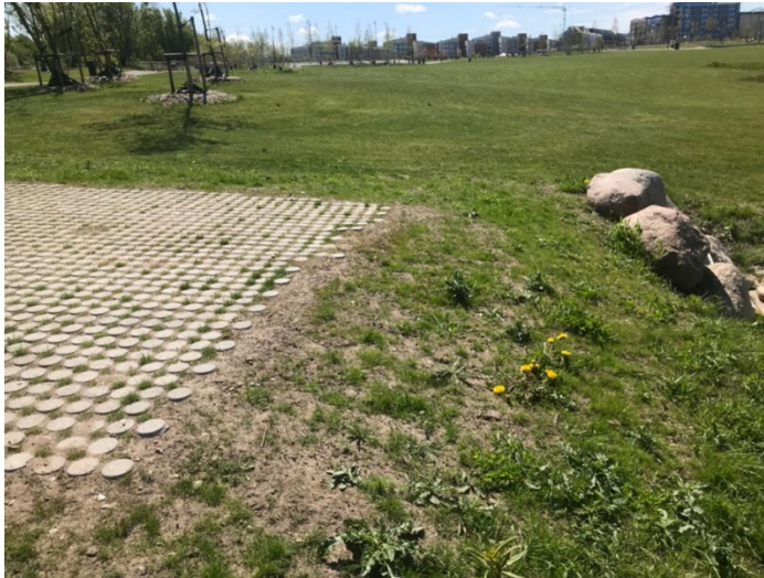
Bild 11: Stenläggning som slutar vid en slänt kan innebära en fallrisk.
