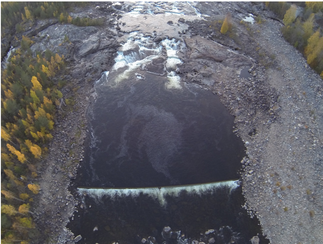
Bild 5. Den djupa poolen i Baggböleforsen där betongtröskeln syns i bildens nedre del, vattenflöde 10 m 3 /s. Foto: Vattenfall
