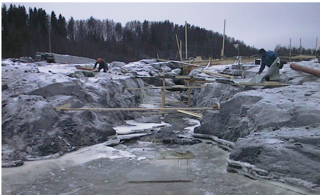
Bild 4. Pooltrappan under byggnation i Baggböleforsen 1998. Foto: Vattenfall
