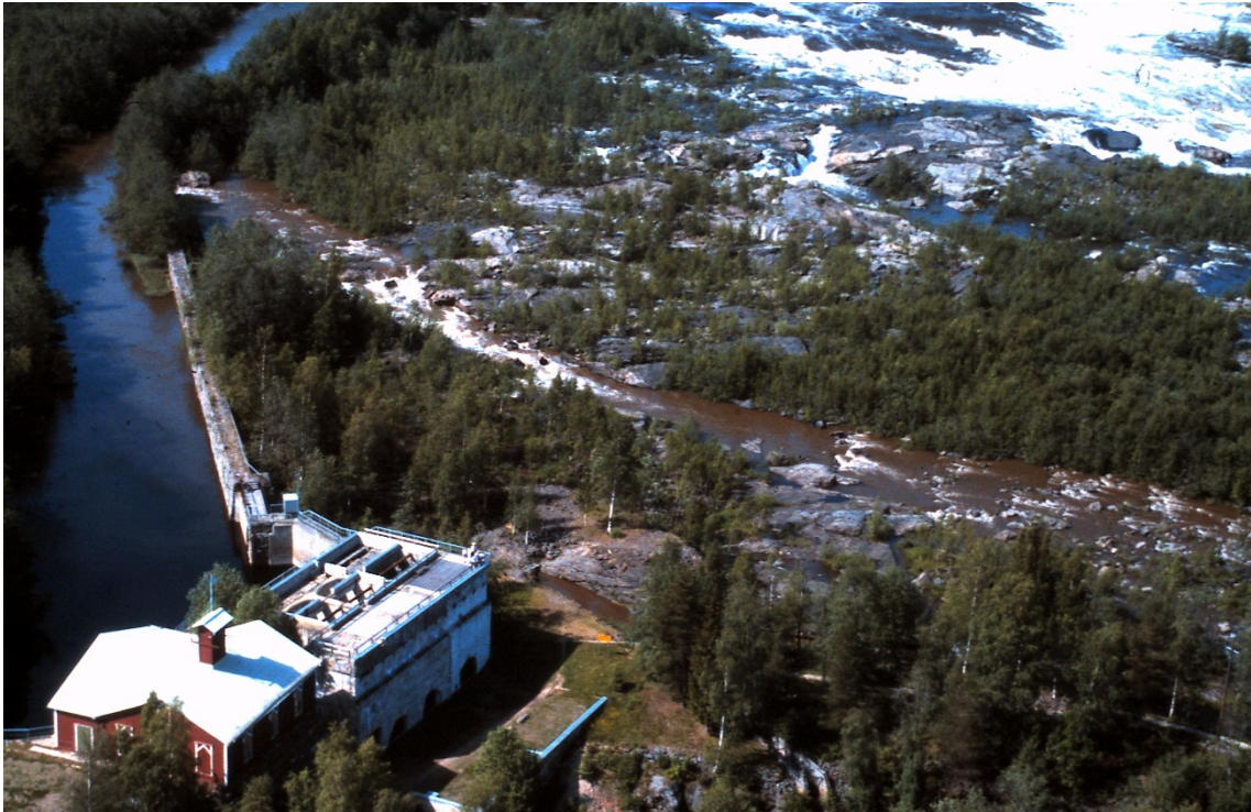
Bild 3. Baggböleforsen vid högvatten, högvattenfåran närmast i bild leder fisken förbi forsens. Foto: Vattenfall.
