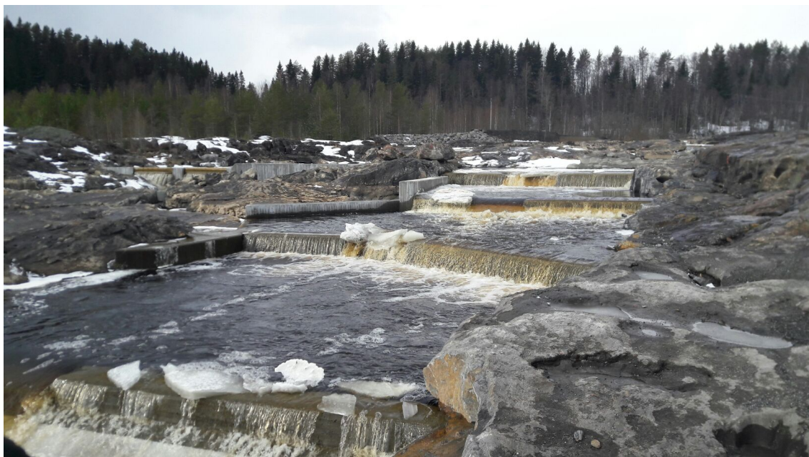
Bild 6. En pooltrappa byggdes i Baggböleforsen under 2016-2017, senhöst-vår, för att underlätta för lax och öring att ta sig vidare uppströms. Åtgärden var färdigställd inför vandringsäsongen 2017.
