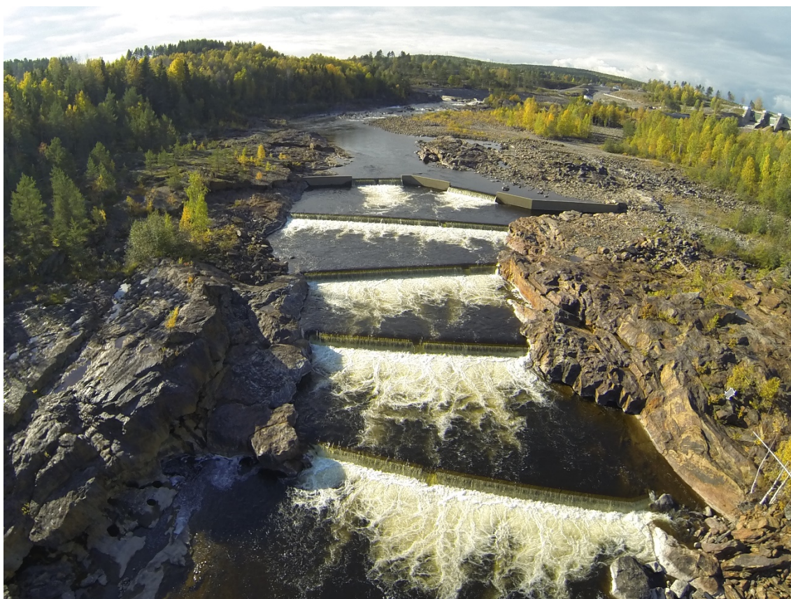
Bild 7. Betongrösklar vid Kungsmofallen som anlades 2011/2012 med nedsänkningar underlättar fiskvandring av lax och öring förbi den tidigare svårpasserade forsen.
