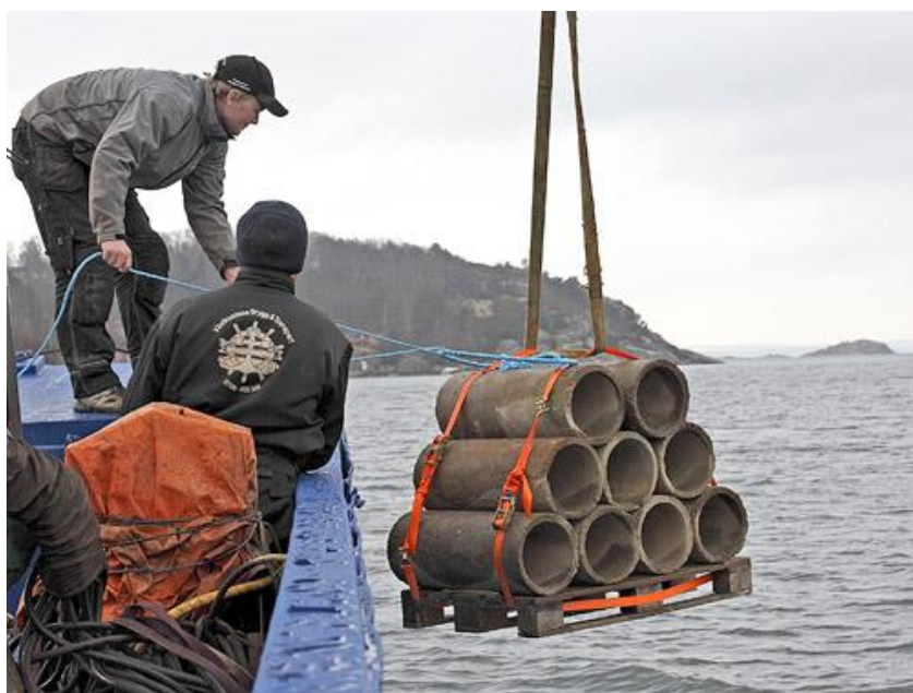
Figur 28 Sammanbundna betongrör som fungerar som konstgjort rev sänks ner i fjorden utanför Tjörn. Foto: Projekt 8-fjordar, med tillstånd.
