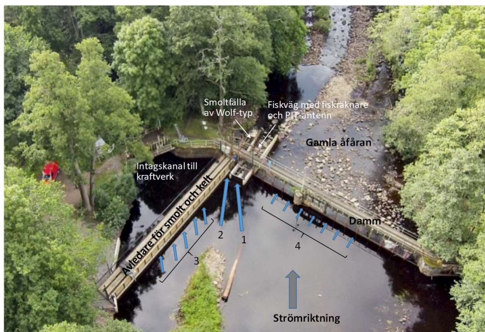
Figur 2. Dammen uppströms Strömsbro kraftverk i Testeboån. År 2014 färdigställdes en avledare i syfte att hindra passerande smolt och kelt från att hamna i intagskanalen till kraftverket. Funktionen på denna avledare är dock oklar då smolt observerats kunna ta sig genom avledarens fingaller och in i kraftverket. Vid märkningsförsöken 2016 och 2017 kunde smolten vandra ut endast via fiskräknaren (1), smoltfällan (2) eller genom avledaren och via kraftverket (3). Under år då vattenföringen under smoltutvandringen överskrider ca 10,5 \text{ m}^3/\text{s} går även en del av vattnet (och smolten) över dammen (4). Se text för detaljer. Foto: Fiskevårdsteknik AB.
