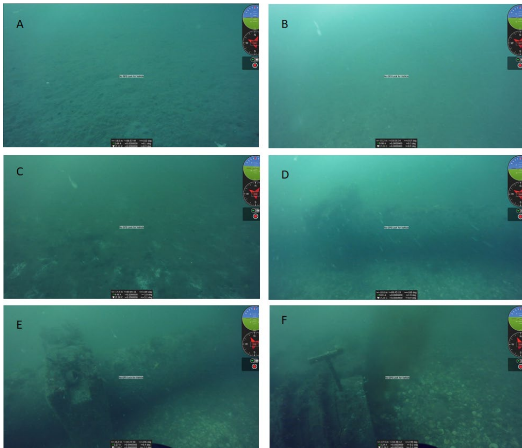
Figur 16. Bilder från videodokumentation 2021. Bild a) och b) avser transekt 1 och 2, ca 200 meter norr- respektive söder om tuben. Bild c) och d) avser transekt 1 och 2, ca 20 meter från tuben respektive ett fåtal meter från tuben. Bild e) och f) visar bilder från filmning längs tuben. Bild e) visar påväxt av alger på tubens ovansida samt en krabbtaska och sjöstjärnor. Bild f) visar ansamling av döda skal vid tubens mynning.
