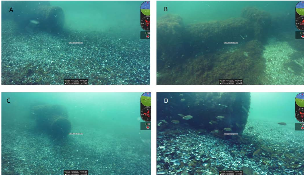
Figur 12. A) Musselskal utanför tubens mynning. B) Påväxt av brun- och rödalger. C) Vall av dött organiskt material vid tubens mynning, utan utflöde. D) Stensultror vid tubens mynning.
