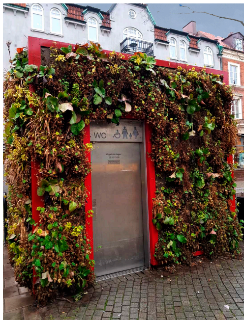
Vinterbild av växtvägg på offentlig toalett på Konsul Olssons plats i Helsingborg. Foto: Katrin Jansson.
