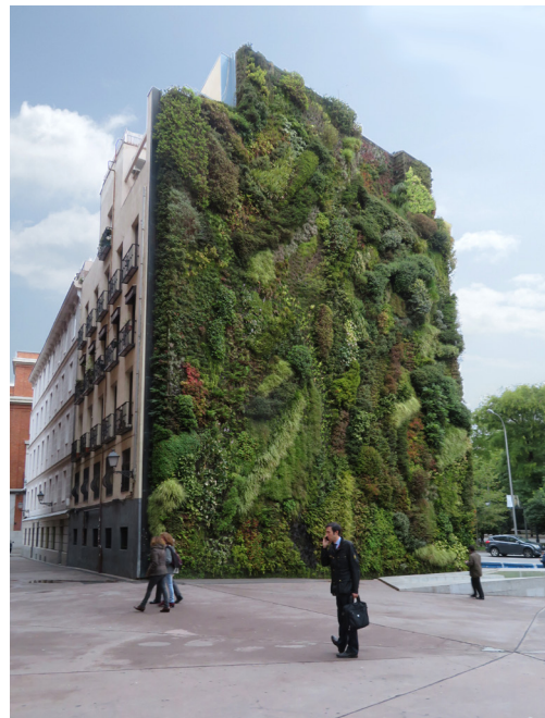
Växtväggar kan ha en avkylande effekt i varmare klimat. Bilden visar växtväggen vid torget i anslutning till Caixa-Forum i Madrid, designad av Patrick Blanc. Foto: Göran Nilsson.
