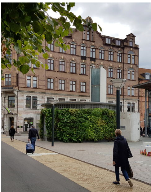
Sommarbild av växtvägg på pumphuset vid Sundstorget i Helsingborg. Foto: Katrin Jansson.
