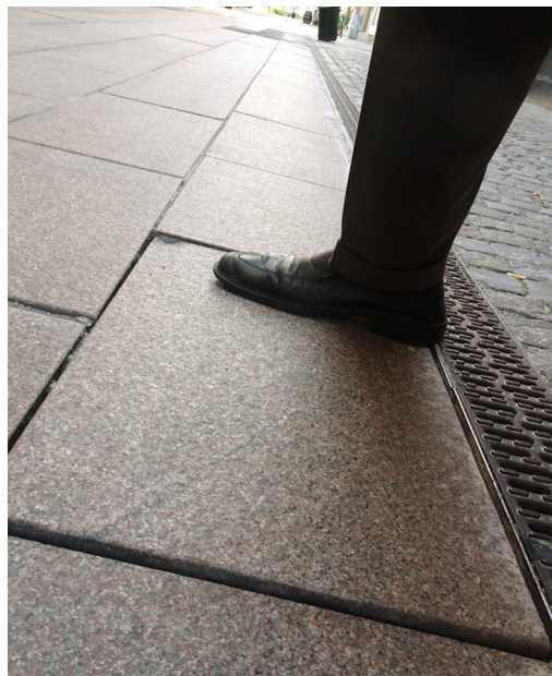
Bild 11. En beläggning med bortpumpad fog som gör att plattan vickar när man går på den. Foto: Kurt Johansson.
