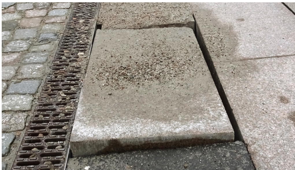
Bild 9. Fog- och sättmaterial har haft för stor finandel (stenmjöl) som pumpats bort och fogen och delar av sättlagret har försvunnit. Distanser saknas. Foto: Kurt Johansson.
