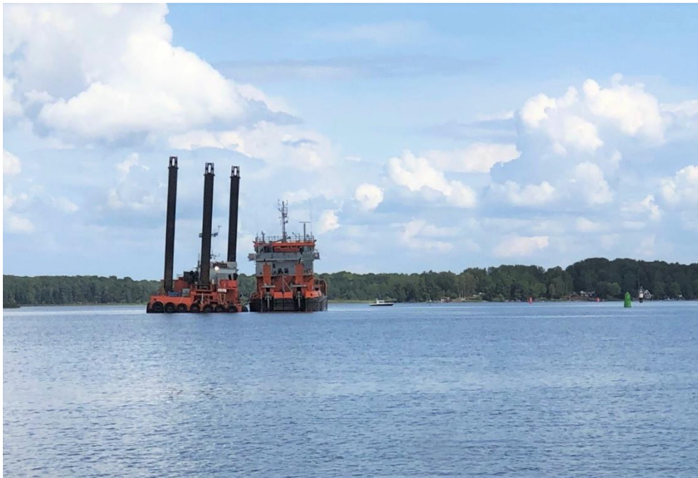
Farledsmuddring pågick utanför Köping i Galten sommaren 2021
