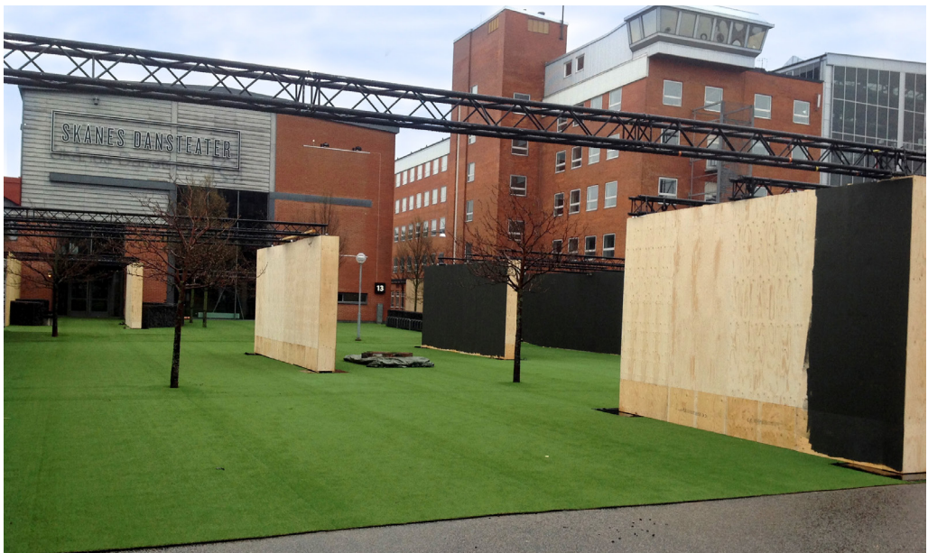
Väggarna och konstgräset var på plats innan planteringarna kunde anläggas. Foto: Karin Svensson.
