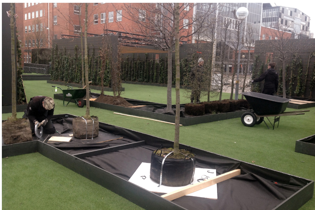
Träden förankrades med hjälp av spikband i skivor av plywood. Foto: Karin Svensson.
