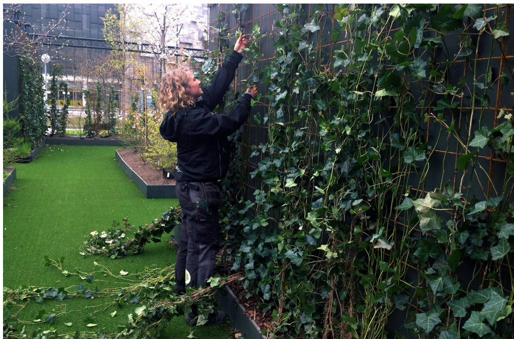
Väggarna kläddes med murgröna som fästes i armeringsnäten. Foto: Karin Svensson.
