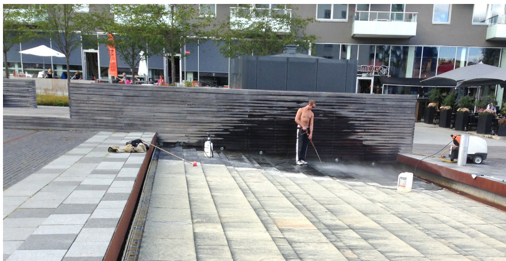
Både i Danmark och i Sverige säger de intervjuade att det är samarbetet mellan beställaren och entreprenören som är det viktigaste för att få bra kvalitet i skötselutförandet. Foto: Göran Nilsson.
