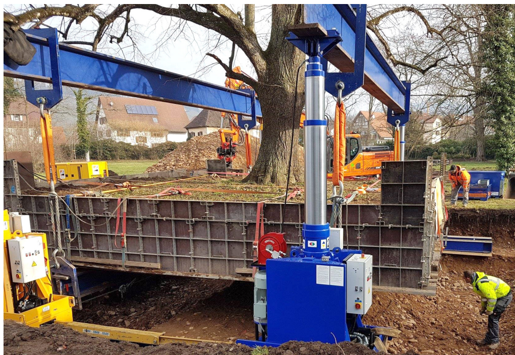
Flytt av jättestort träd med domkraftsteknik. Foto: Opitz International.
